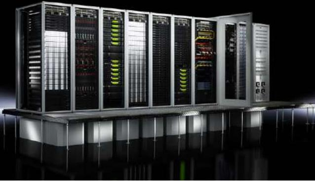
El centro de datos estandarizado se monta en una sala convencional dentro del concepto de cubo para pasillo de aire caliente o frío.
